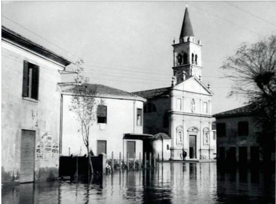
Figura 22: Guarda Veneta alluvionata
