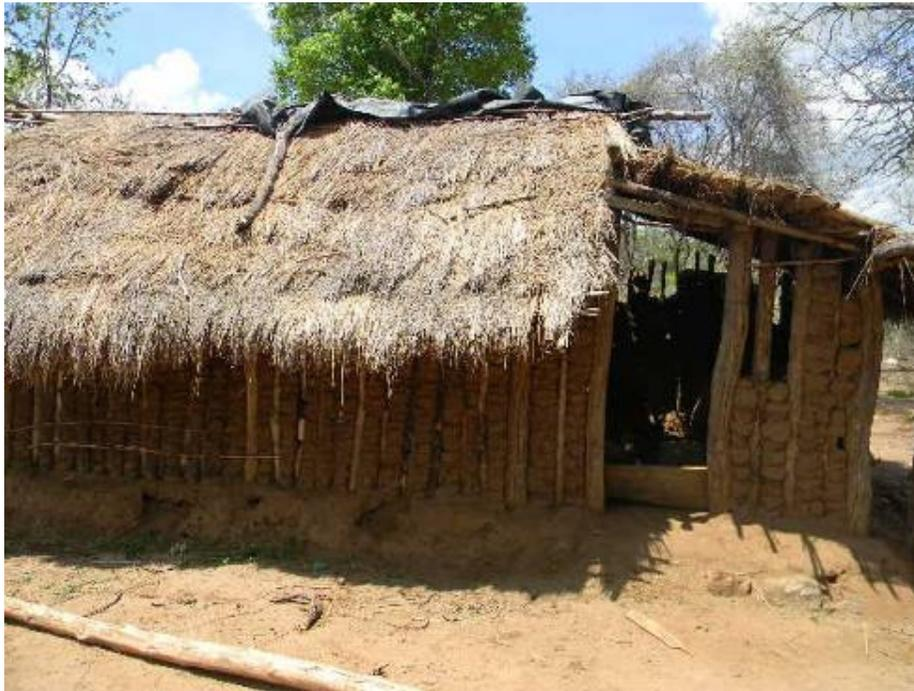
Fig. 14. Abitazione vedda con struttura di pali e fango essiccato e tetto in paglia
