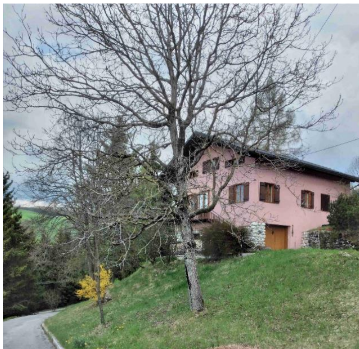
Fig. 19 – Sul lato est si vede come la casa poggia e ingloba il terreno retrostante. ERB , 3/05/2022.
