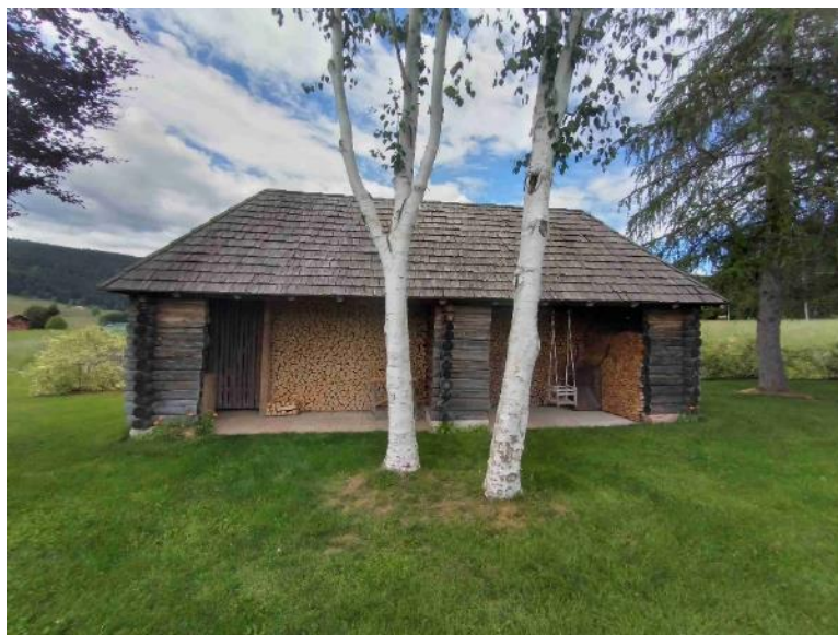
Fig. 60 – La legnaia nella baracca a blockbau a casa del signor Tita. ERB , 10/06/2022, Asiago.
