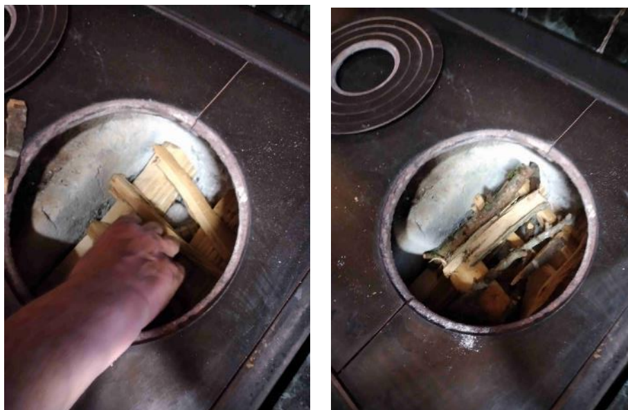
Fig. 53a e 53b – Costruzione della piramide di legno con i rispar nel fornello della stufa. ERB , 17/05/2022, Asiago.
