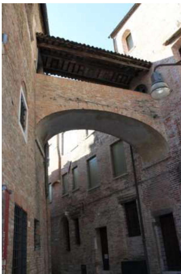
Figura 18: Pojolus , passaggio coperto e sopraelevato tra le canoniche “nuove” e “vecchie”, XIII secolo.
