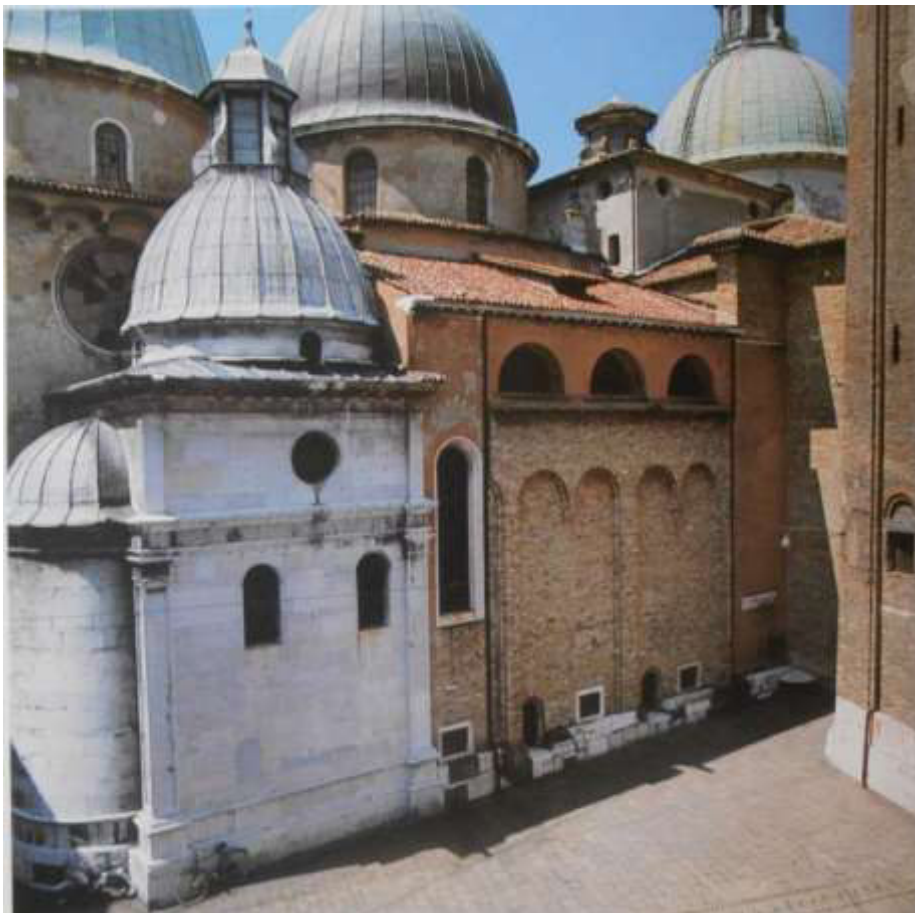
Figura 16: Lato settentrionale del Duomo con le murature originali.
