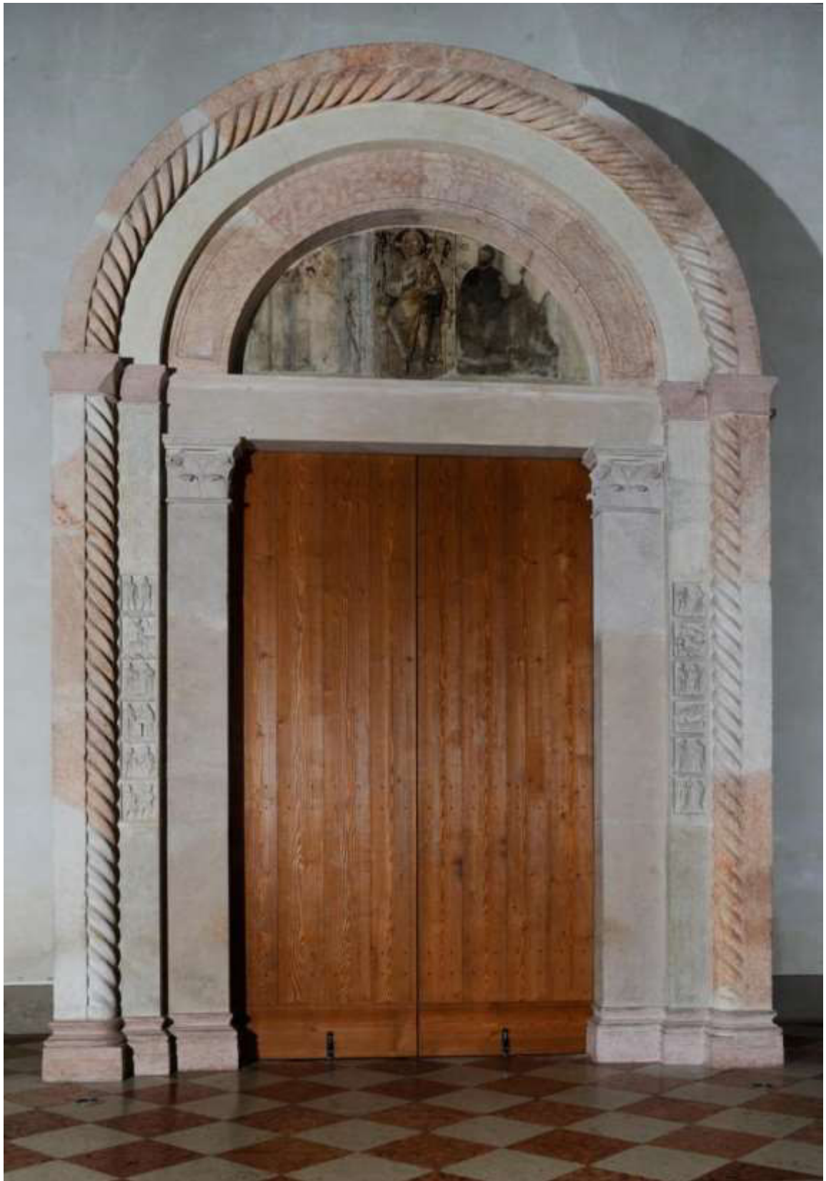
Figura 20: Il portale romanico del Duomo. Dal 2005 è visibile, così ricostruito, all'interno del Duomo, nella parete di controfacciata. La struttura completa misura circa 4 m; ogni formella circa 30 cm per 22 cm. Tutte le formelle erano racchiuse da cornici con tralci vegetali che vennero alienate al momento dello smontaggio, a inizio '800. Con le cornici ogni stipite misurava circa 40 cm di larghezza. (Museo Diocesano di Arte Sacra- Treviso).
