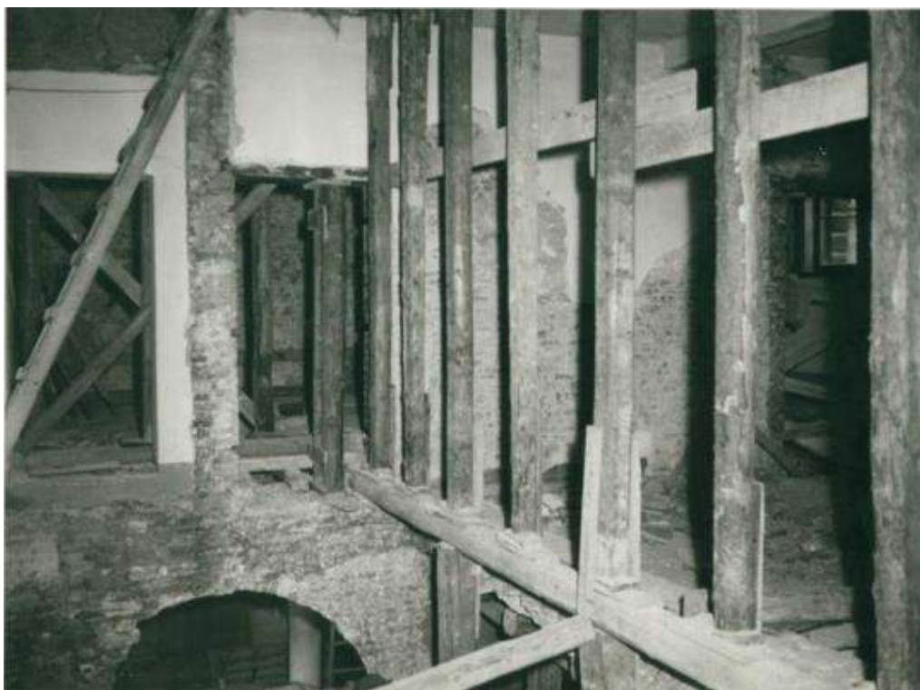
Figura 44: Palazzo Vescovile durante i lavori del 1959-1960. (Archivio dell'ufficio amministrazione della Curia Vescovile di Treviso)
