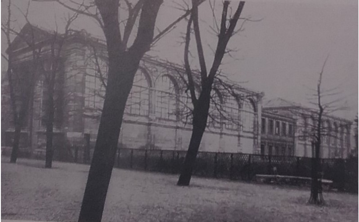
Figura 5 - L'edificio del Jeu de Paume a seguito della ristrutturazione del 1921-1922 in Bonnefoy, Jeu de Paume: histoire , cit., p. 22.
