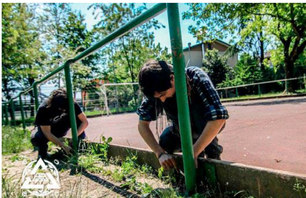
Fig. 5: Lavori di riqualificazione all'interno del parco Milcovich
