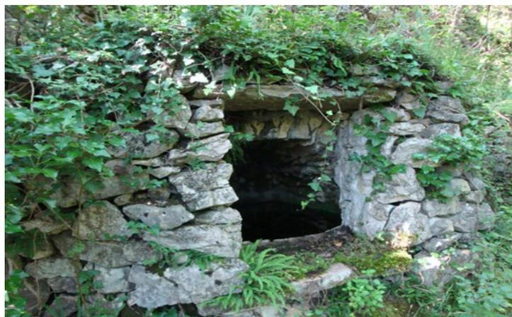
Fig.18. Pozzo costruito con il catino in cemento e i muri con soffitto con pezzi di roccia per far percolare l'acqua di filtrazione.(foto propria, 2015)
