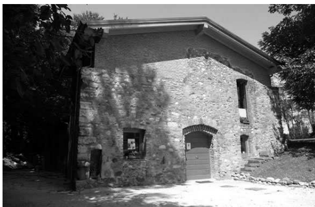
Figura 17 Esterno del mulino ristrutturato (fonte: www.farinedelgarda.it )
