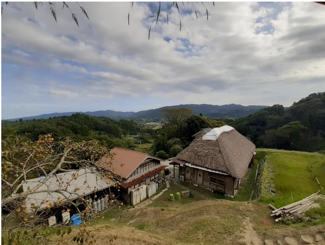
Casa di Yoshiki Ayashi a Kamogawa
