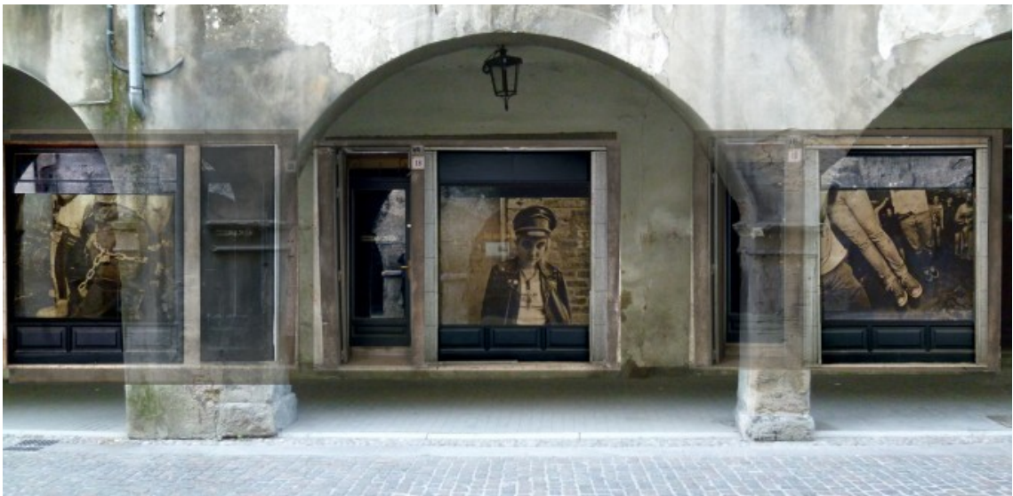
48. Codalunga visto dall'esterno di Via Martiri della Libertà.
