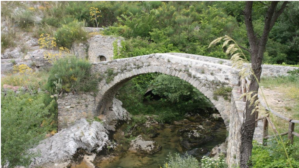
Figura 36: Ruleri del vecchio mulino ad acqua e il ponte romano.
