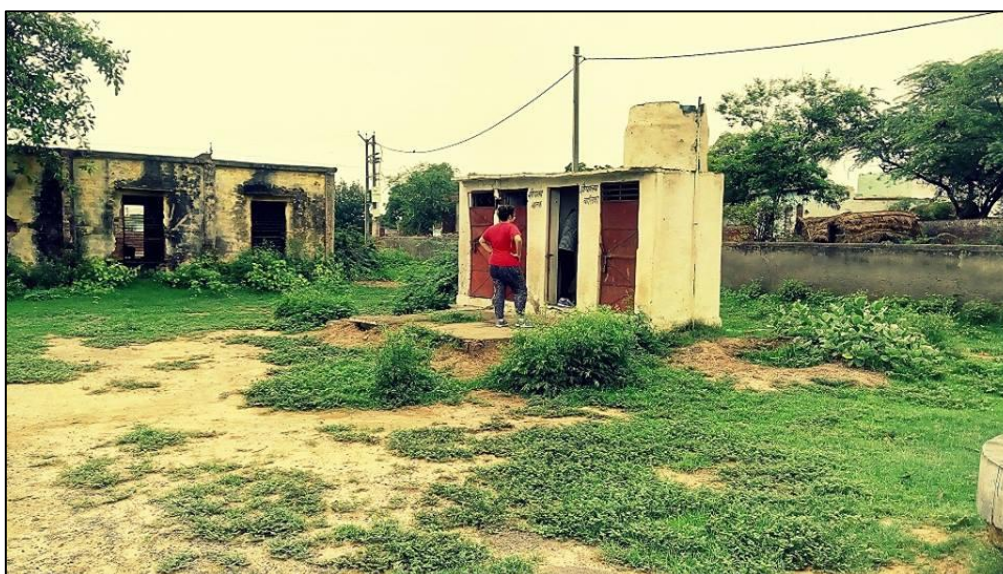
FIGURA 13: BAGNI DISMESSI NELLA SCUOLA DI GOVERNO DI ROHI
