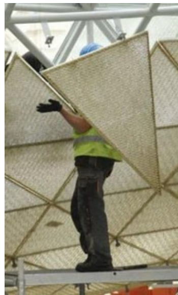
Particolare del montaggio dei singoli componenti del tetto
