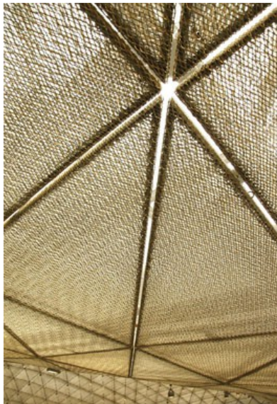
Particolare interno della struttura del tetto in vetro e acciaio
