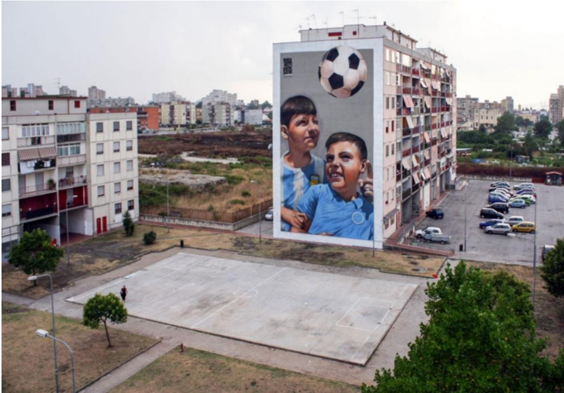
13 Rosk&Loste, "Chi è vulut bene nun s'o scorda", Ponticelli, prima dei lavori area verde.
