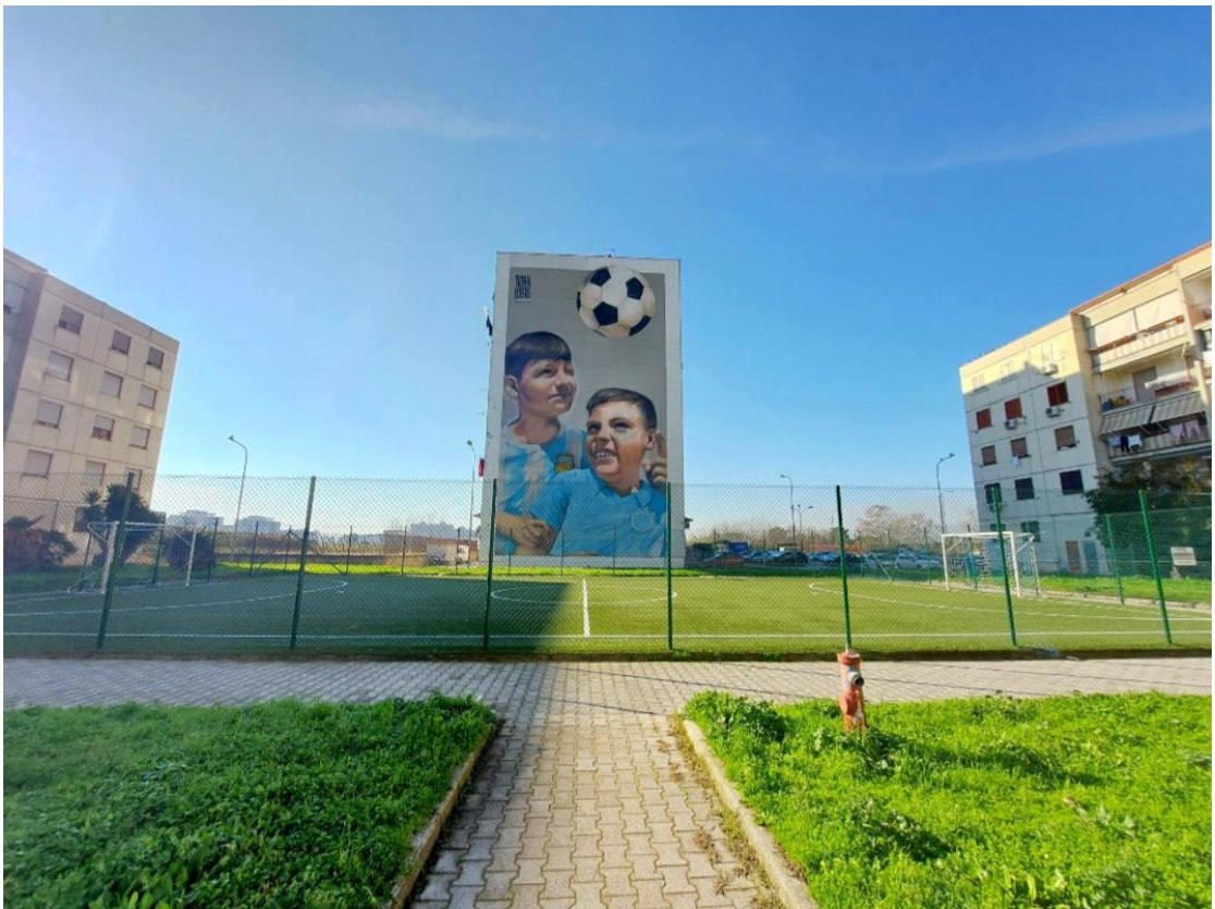
14 Rosk&Loste, "Chi è vulut bene nun s'o scorda", Ponticelli, post lavori realizzazione area verde.
