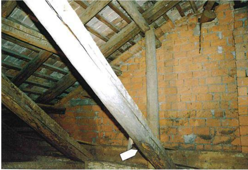
Fig. 25. Degrado causato dall'attacco di insetti nel puntone inferiore delle capriate dell'aula centrale del Museo San Paolo, Monselice.
