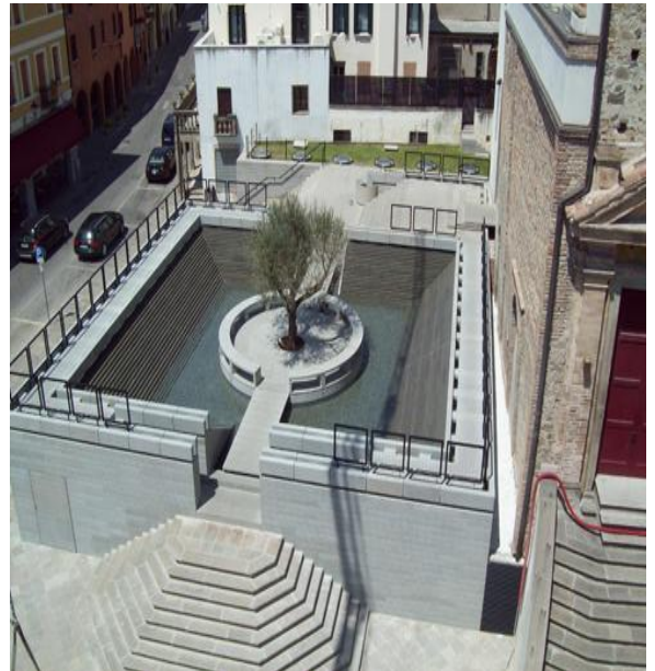
Fig. 18. Fontana esterna della chiesa di San Paolo, Moselice.
