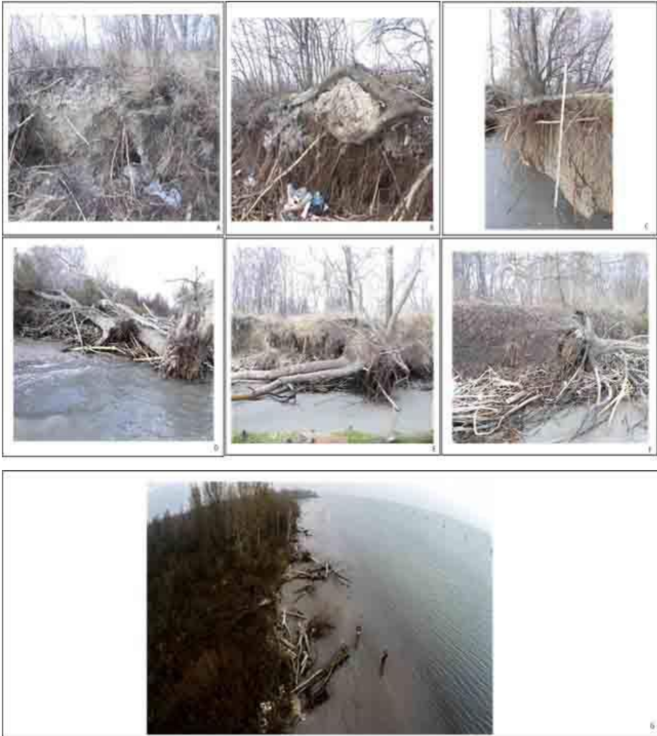
Figura 66. Erosione nella vegetazione della cassa di colmata B. Aree centro-Sud. Fotografie del 16 gennaio 2015.
