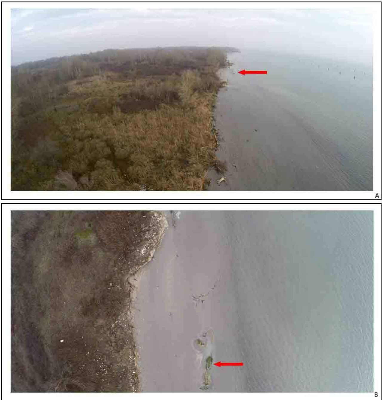
Figura 62. Erosione nell'area centro-Sud (A), e dettaglio di una zona erosa (B) lungo la linea di riva della cassa di colmata B. Fotografie del 16 gennaio 2015.
